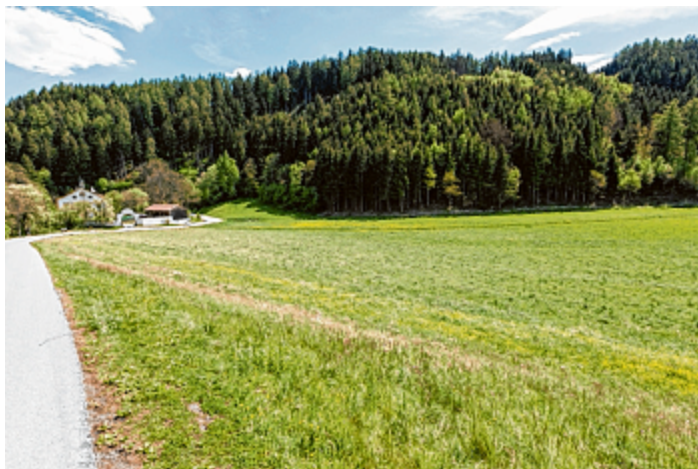
Entlang des Kirchweges sollen 25 Parkplätze entstehen. Ein Retentionsbecken samt Damm soll im Hochwasserfall mehr Schutz bieten. Fotos: Hammerle
