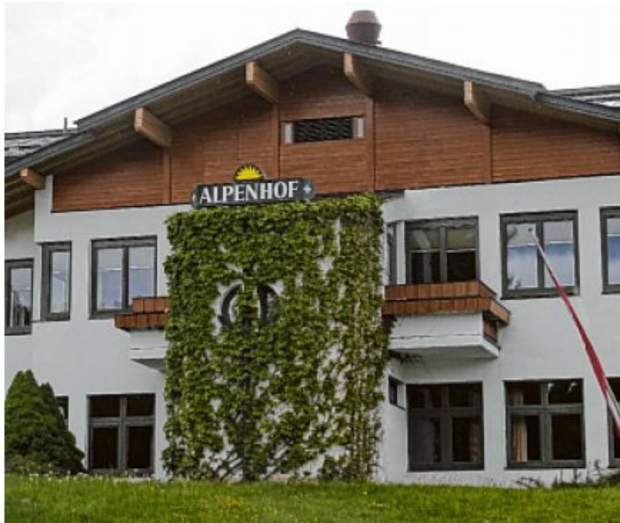
Die Pläne für den Alpenhof sorgen weiter für Aufregung.
